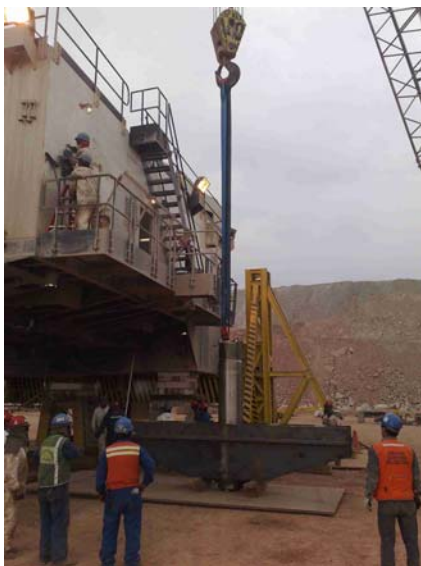
Fuente: 19122007050.JPG Introducir el puente
