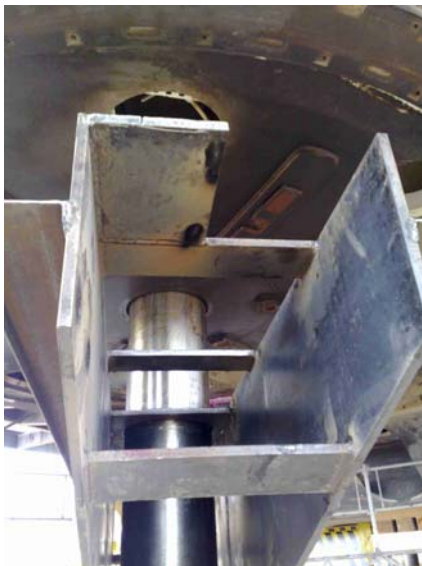
Fuente: 19122007055.JPG Introducir el puente, sin fresadora
