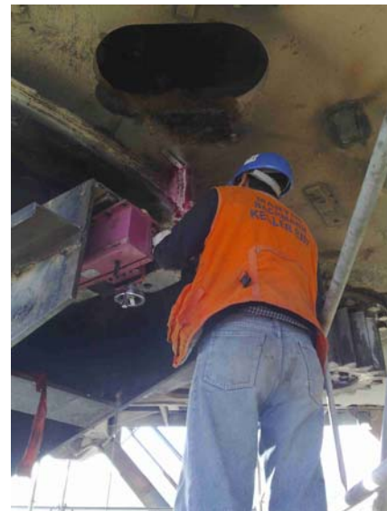
Fuente: 20122007064.JPG Colocar la fresadora en el puente
